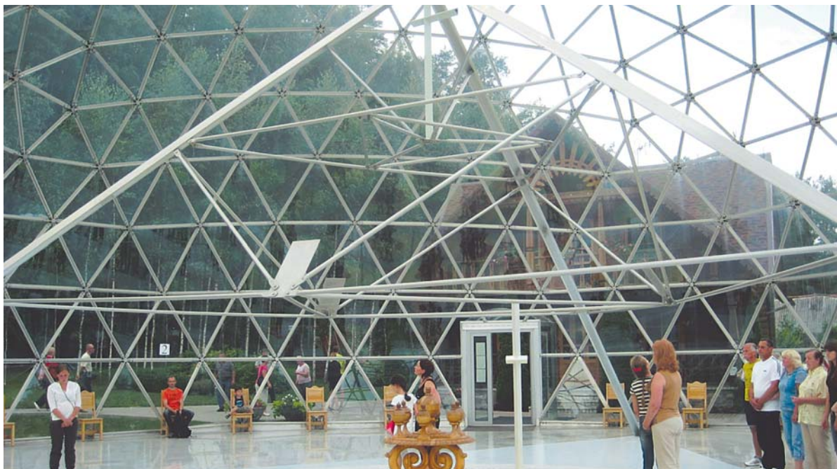
Metalų konstrukcijos satanistės priedermės ir masonų ženklų statinys. Jis ganėtinai įspūdingas ir viliojantis. Tai jaukas spąstams.
